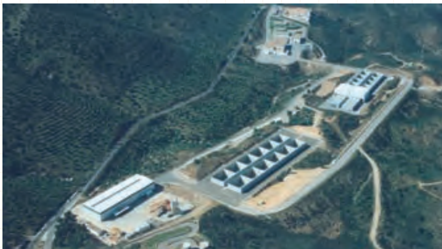
Centro de almacenamiento en superficie de residuos de baja y media actividad de El Cabril. Hornachuelos (Córdoba)
