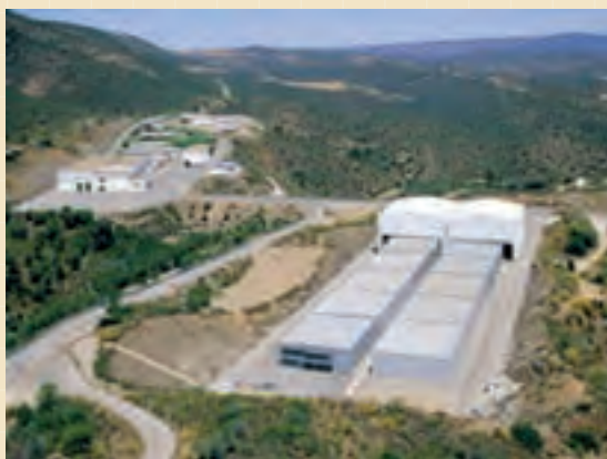
Centro de almacenamiento en superficie de El Cabril. Hornachuelos (Córdoba)
